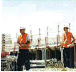
Un cantiere. /LAPRESSE
